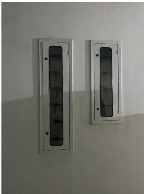
Figura 17: Quadro Instalações de Gases – Centro Cirúrgico
