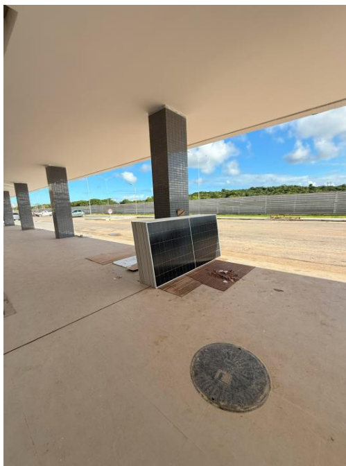
Figura 29: Painéis Fotovoltaicos em instalação
