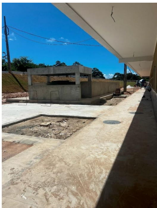
Figura 26: Central de Utilidades – Área Externa
