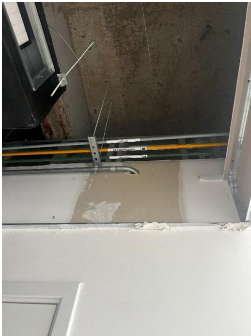
Figura 21: Instalações Gases - Identificação
