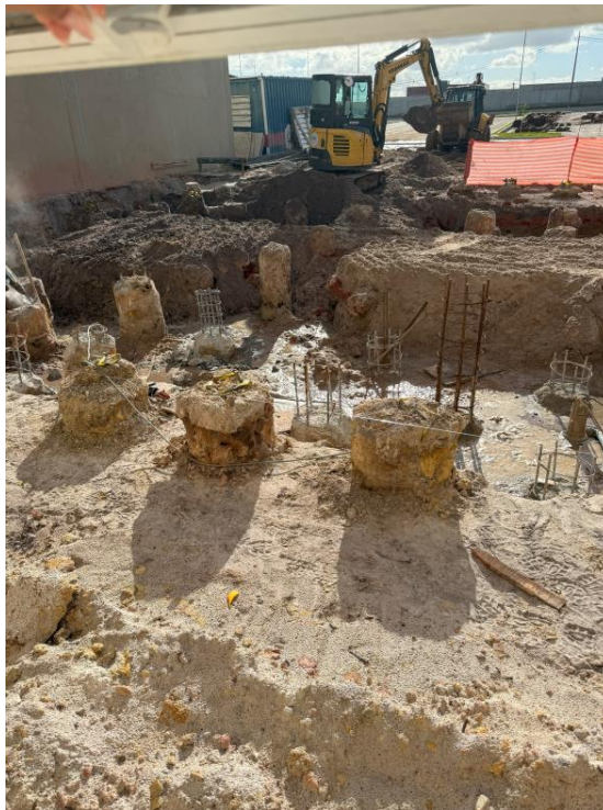
Figura 53: Área do Bunker com fundação iniciada
