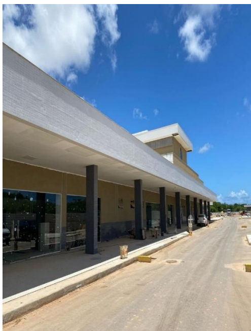
Figura 2: Fachada Ambulatório e Emergência
