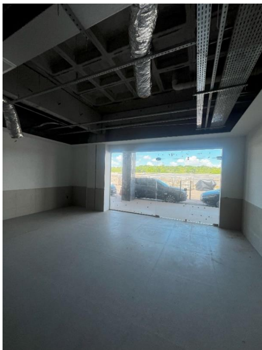
Figura 4: Acesso Espera Emergência
