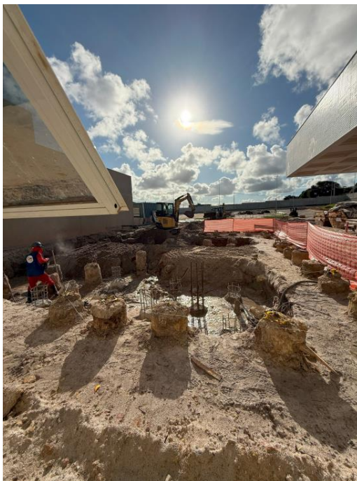
Figura 52: Área do Bunker com fundação iniciada
