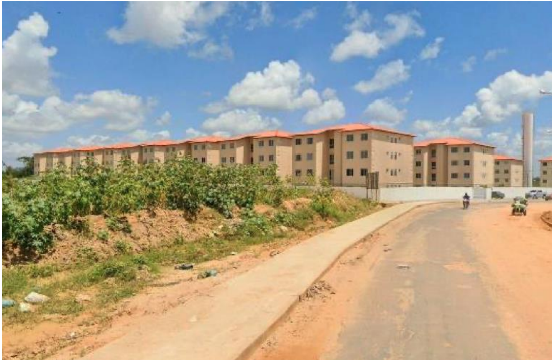
Figura Nº 15: Área destinada para a construção de moradias populares no bairro Porto Dantas, Aracaju-SE – 2019. Fonte: Streetview.
